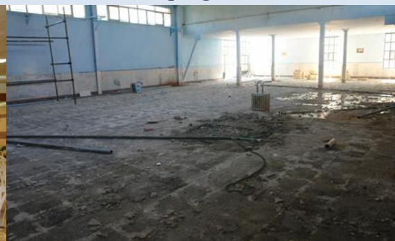
سلف سرویس پردیس فنی و مهندسی (قبل از تعمیر)
